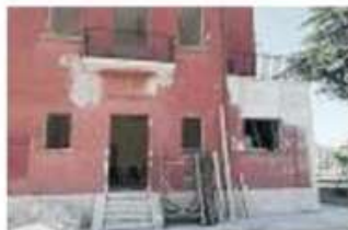
GLI INTERVENTI I lavori in corso nell'ex casa cantoniera Anas
