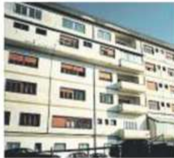
LA STRUTTURA L'ospedale di Cerreto
